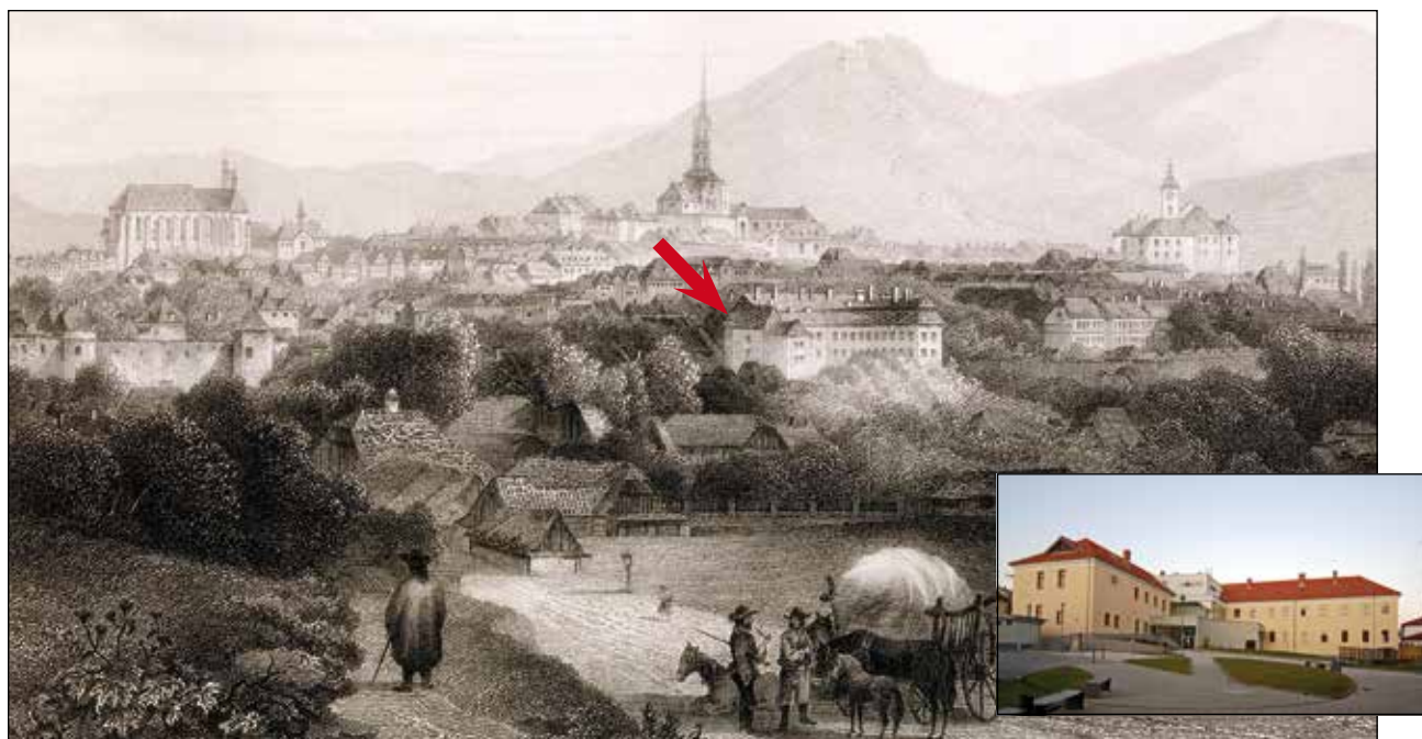
Ryc. 82. Kolegium jezuickie w Lewoczy powstało po przebudowie dawnego klasztoru kartuzów. Po prawej stan obecny.
