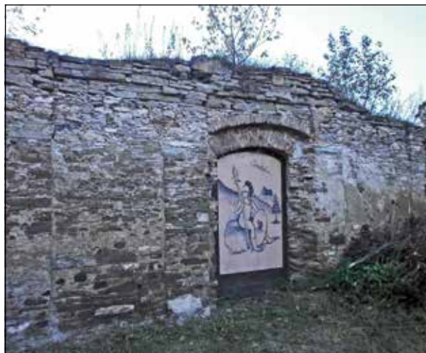
Ryc. 38. Obecny stan domu żupnego z symbolem kopijników.
