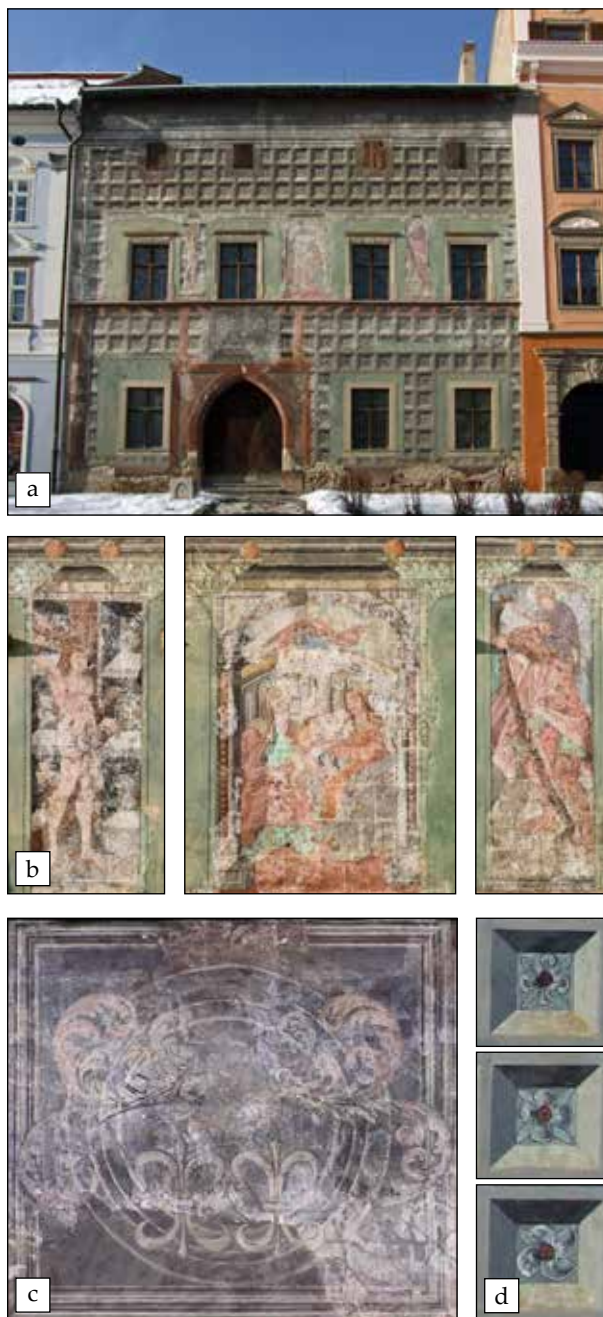
Ryc. 5. Fasada Domu Krupeka (nr 44) na placu Mistrza Pawła w Lewoczy: a) widok ogólny b) św. Sebastian, św. Anna Samotrzecia (Metercia), św. Krzysztof, c) malowany herb rodu Krupeków nad portalem wejściowym, d) przykłady realizacji motywu róży mistycznej ( rosa mystica ) w poszczególnych kasetonach.
