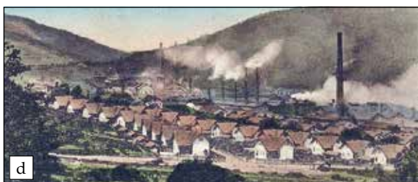
Ryc. 36. Zakład w Słowinkach był ściśle połączony z hutą w Krompachach: a) widok obecny Krompachów, b) obiekt administracyjny huty z 1891 r., c) jeden z zachowanych obiektów starej huty w lokalizacji Stara Masza, d) teren huty Nadhornadzkiej Spółki Hutniczej w Krompachach na dawnej widokówce.
