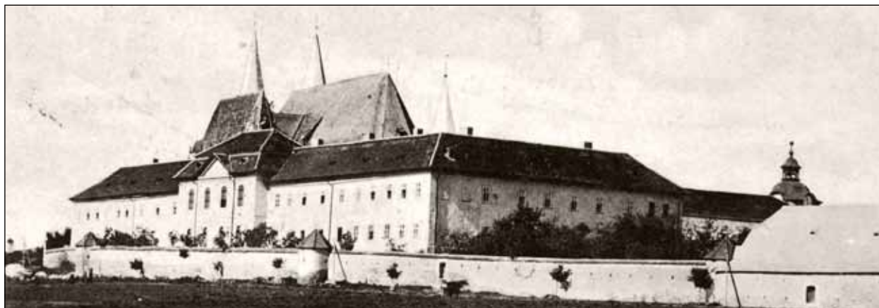
Obr. 81. Pôvodné jezuitské kolégium na Spišskej Kapitule bolo prestavané na kňazský seminár.
