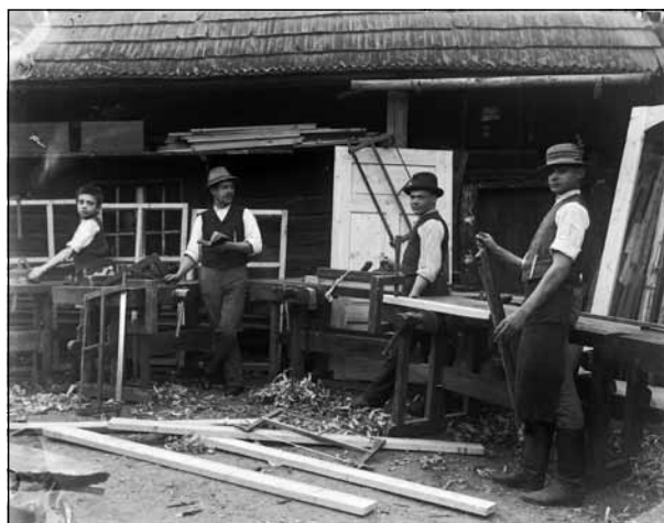
Obr. 21. Dedinská stolárska dielňa na prelome 19. a 20. storočia.
