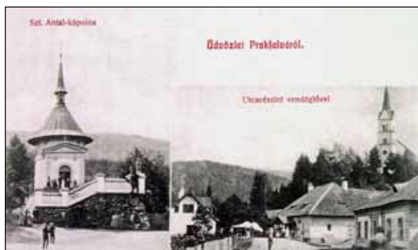
Obr. 24. Prakovce s hutou Ludmila patrili k dôležitým železiarňam nadregionálneho významu. Na obrázku Kaplnka svätého Antona a Kostol svätej Ludmily.
