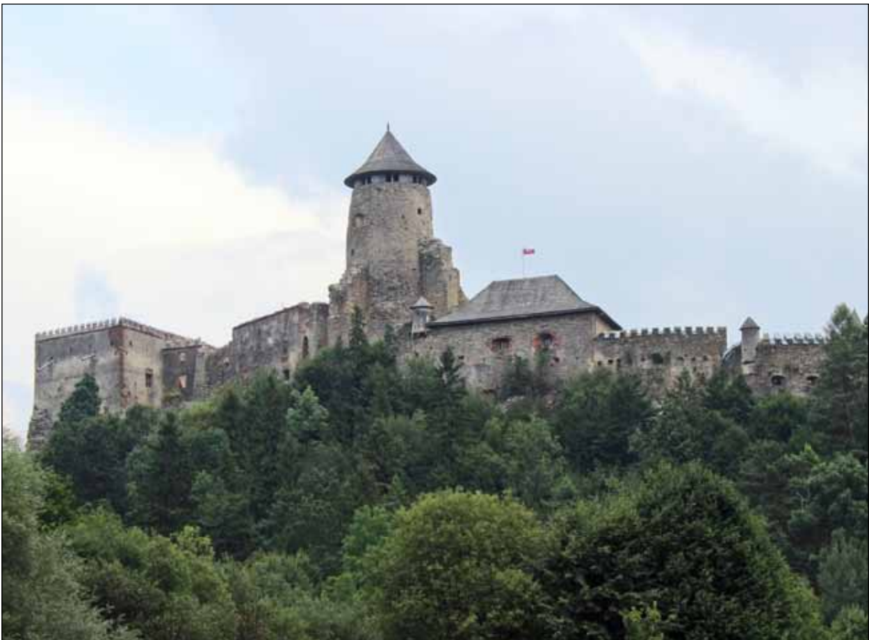
Obr. 28. Súčasný stav Ľubovnianskeho hradu. Pohľad od skanzenu.
