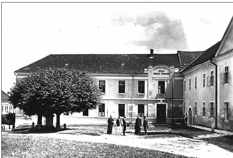
Obr. 68. Budova učiteľskej preparandie za biskupa Alexandra Párvyho.
