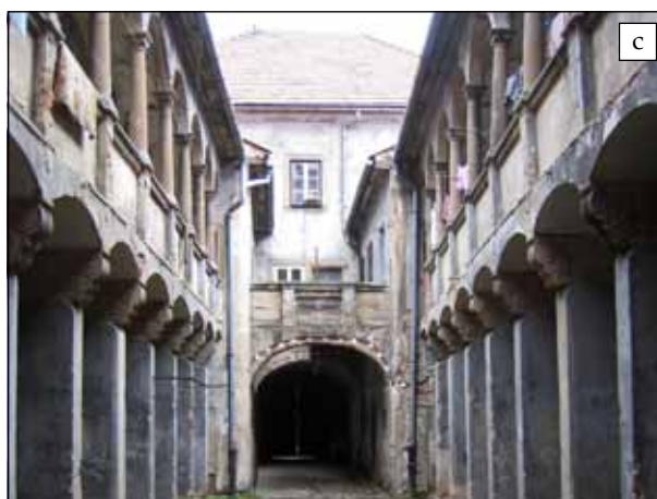
Obr. 44. Dom č. 43 (nazývaný aj Greffov alebo Mariášiovský dom) na Námestí Majstra Pavla v Levoči: a) vstupný portál, b) detail výzdoby, c) pohľad do dvora s pavlačami.
