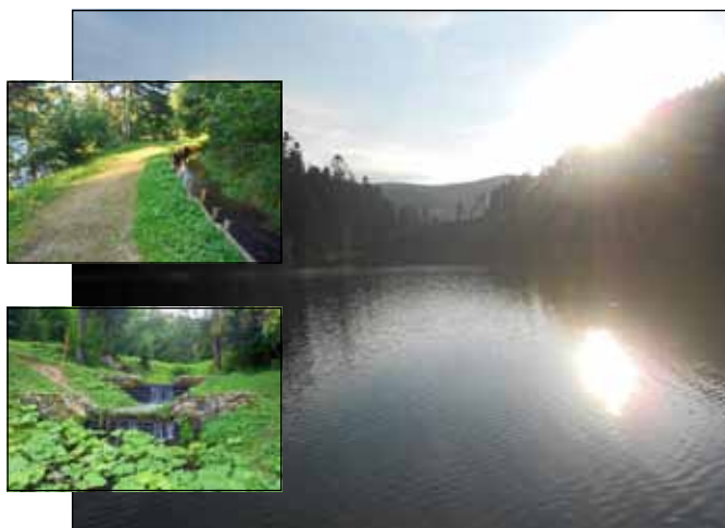
Obr. 28. Uhornianska vodná hrádza dnes (celkový pohľad od východu). Technológia privádzania a odvádzania vody do Uhornianskej hrádze sa nezmenila ani v súčasnosti.
