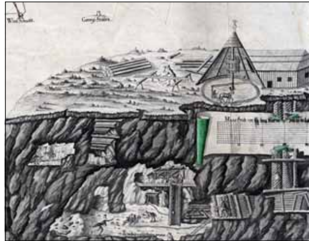
Obr. 11. Výjav z banských prác na prehľadnej mape baní v Smolníku z roku 1748.
