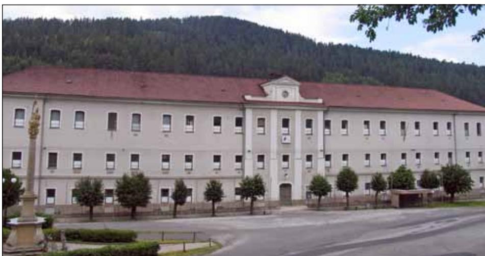
Obr. 14. Objekt správy štátneho mediarskeho podniku a inšpektorského úradu (súčasný stav).
