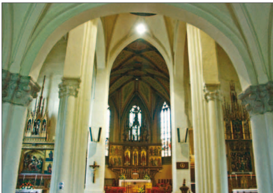
Ryc. 63. Wnętrze kościoła kapitulnego św. Marcina (stan obecny) z przykładami kamieniarki wykonanej przez średniowiecznych mistrzów. Na pierwszym planie XIII-wieczne kolumny romańskie. Wyżej trzy antropomorficzne wsporniki, z których wychodzi gotyckie sklepienie obecnej XV-wiecznej katedry.
