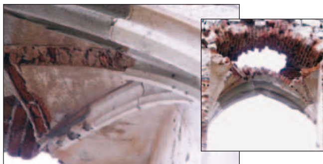
Ryc. 147. Gotycka przebudowa wykusza na południowej ścianie romańskiego pałacu; poniżej: okno na ścianie północnej z przedstawieniem pary królewskiej.
