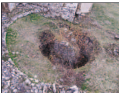
Ryc. 127. Filar środkowy, pozostałość najstarszej okrągłej wieży mieszkalnej z XII w., później przebudowanej na cysterne.
