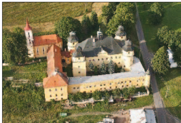
Ryc. 169. Widok z lotu ptaka na kasztel w Spiskim Szczawniku.
