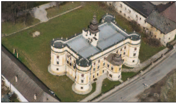
Ryc. 166. Widok z lotu ptaka na przebudowany w stylu barokowym późniejszy kasztel w Markušowcach.
