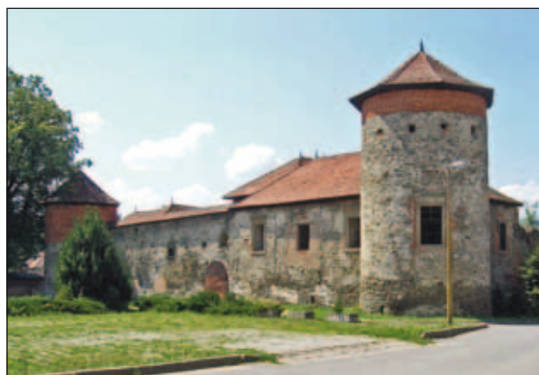
Ryc. 164. Północno-zachodnia część ufortyfikowanego terenu.
