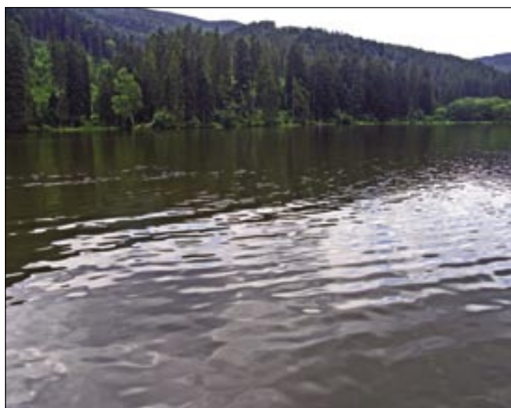
Obr. 9. Typické banské vodné dielo - tajch, od stredoveku zabezpečovalo energiu pre stroje v Gelnickom banskom okruhu (na snímke tajch v Úhornej).
