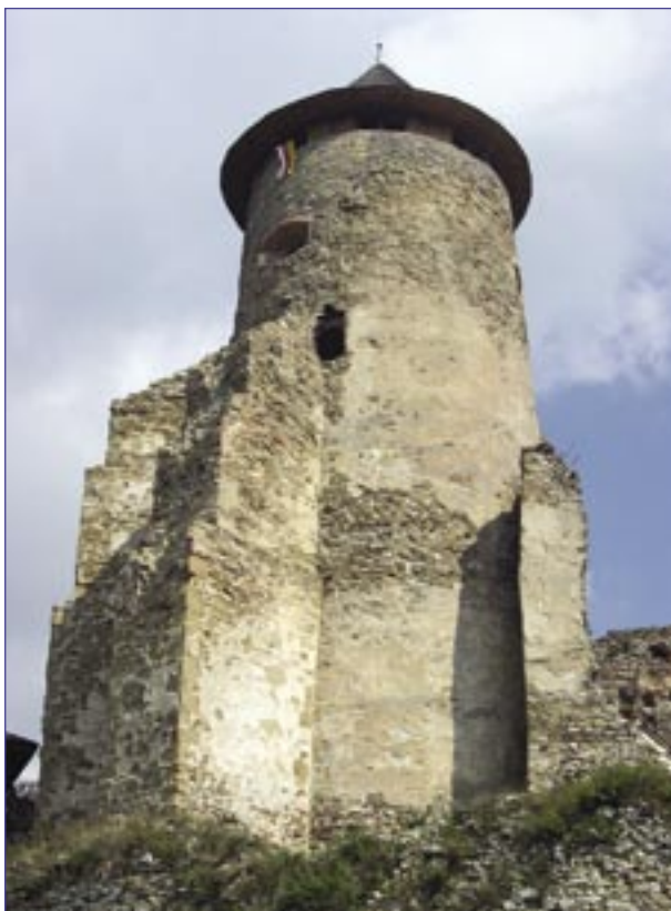
Obr. 159. Neskorostredoveká veža hradu Lubovňa.
