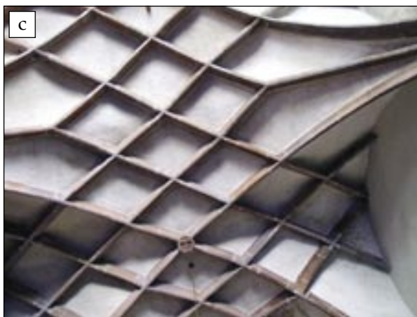
Obr. 108. V klenbových systémoch neskorkej gotiky rebrá postupne prestávali byť nosným prvkom a stávali sa prostriedkom vytvárania komplikovaných dekoratívnych vzorcov: a) Spišská Kapitula, b) Spišský Štortok, c) Červený kláštor.
