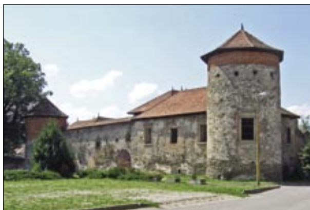
Obr. 164. Severozápadná časť opevneného areálu.
