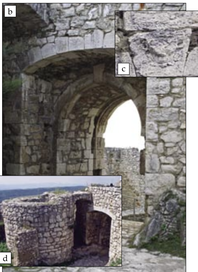
Obr. 130. Spišský hrad: a) pohľad na románsku obrannú vežu v spodnom predhradí so strieľňami, chrániacu prístupovú cestu od spodnej brány k hradu (smer od Spišského Podhradia), b) románska vstupná brána na akropolu, pohľad smerom k románskemu predhradiu, c) detail zdobeného klenáku brány, d) obranná kruhová veža pri vstupnej bráne.
