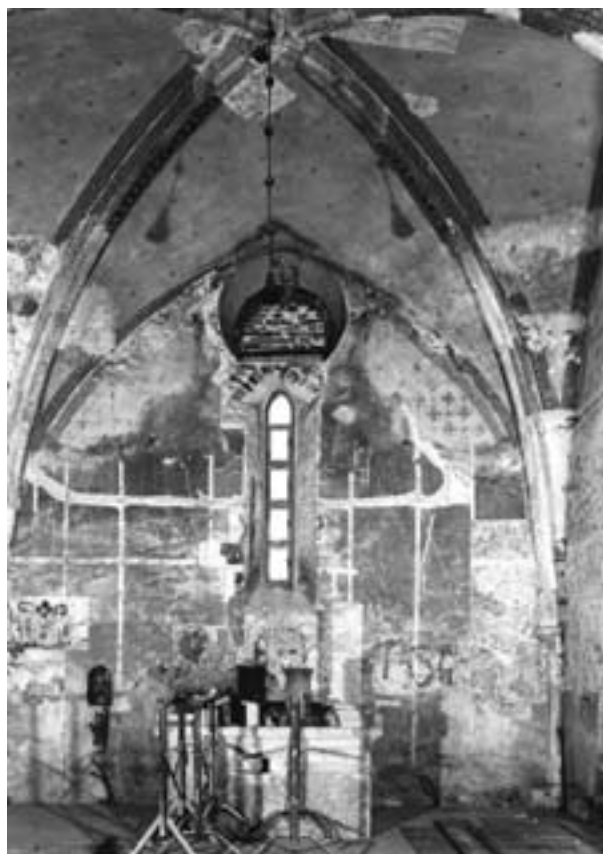
Obr. 1. Pohľad na východnú stenu svätyne v čase reštaurátorského prieskumu, pred reštaurovaním.
