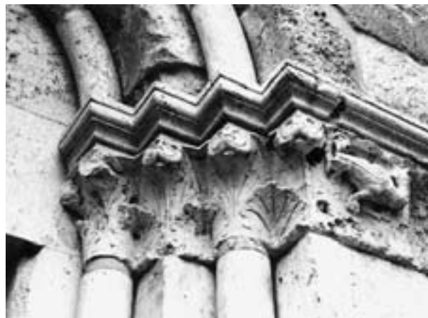
Obr. 7. Ócsa (Maďarsko), bývalý premonštrátsky kostol: pravé ostenie južného portálu.
